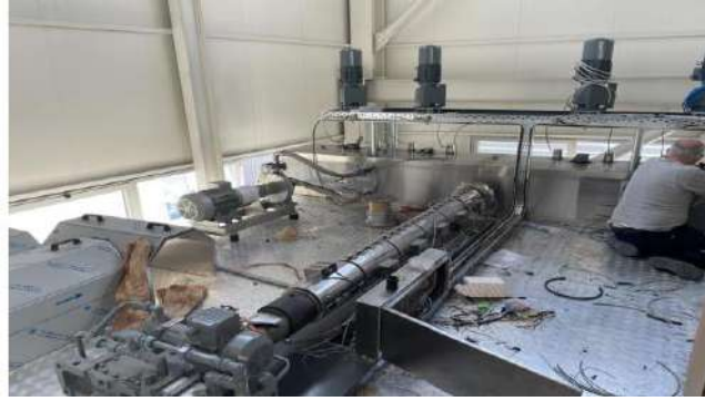
Şekil 3. Ekstruderin yağ tankına bađlanması ve kızgın yağ devirdaim pompası
