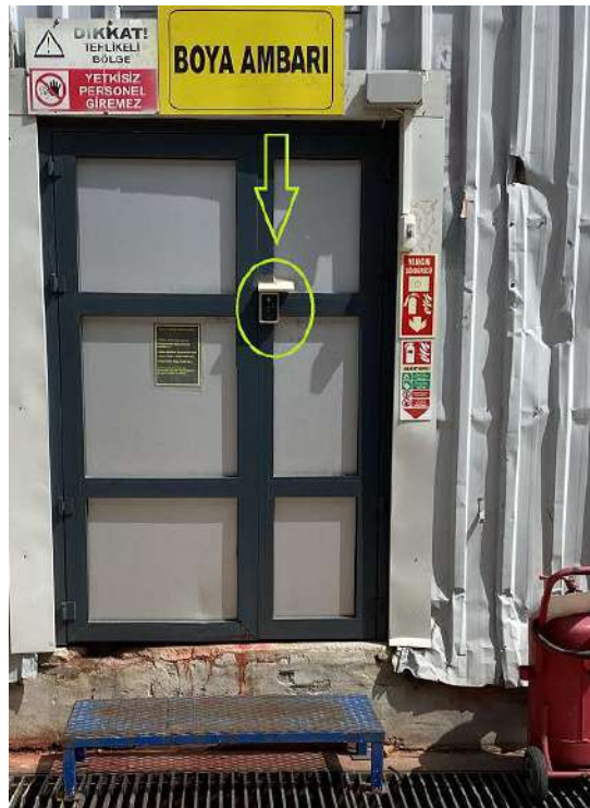
Şekil 1. Boya Ambarı Kart Okutma Sistemi
